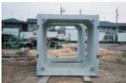
函渠への鍵穴型フランジ取付け状況
